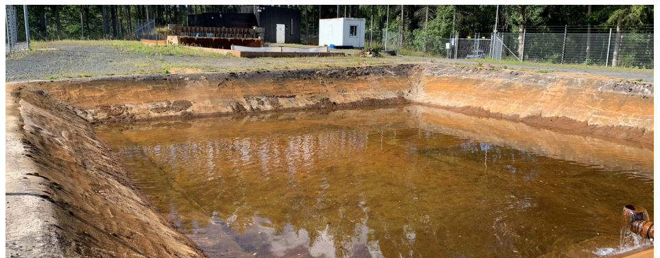
Råvattnet renas i en infiltrationsbassäng som är ett av flera reningssteg innan det håller dricksvattenkvalitet. På bilden syns hur mycket järnet faller ut. Foto: NSVA.
