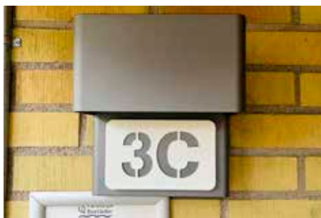
Nya husnummerskyltar har också monterats. Allt i syfte att fräscha upp området.
