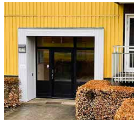
I Perstorps Bostäders handlingsplan för fastigheterna på Tjäderstigen ingår även byte av entrépartier på fastigheterna med adress Tjäderstigen 15-21. Dörrarna blir av samma modell som på Jägaren, det vill säga massiv ek.
